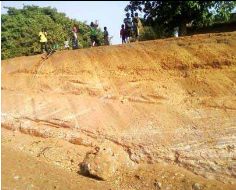
Photo 20 : Talus au Km 17.6
