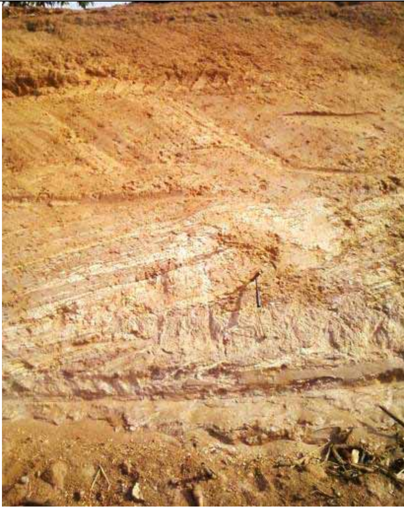
Photo 21: Talus au Km 17.6. On distingue clairement le micro litage des altérites de gneiss
