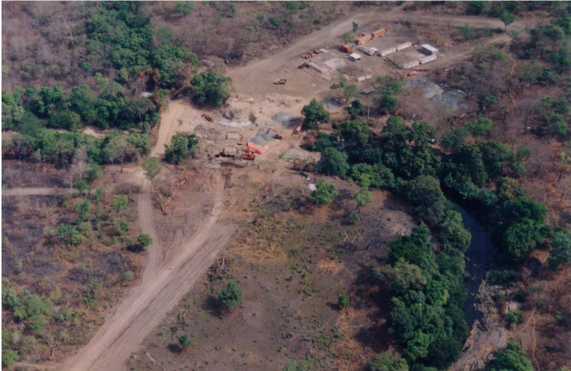
Photo : J-M Bouchez Vue aérienne de la Térou à la Cote 238 pendant la construction du pont le 21 mars 2003.
