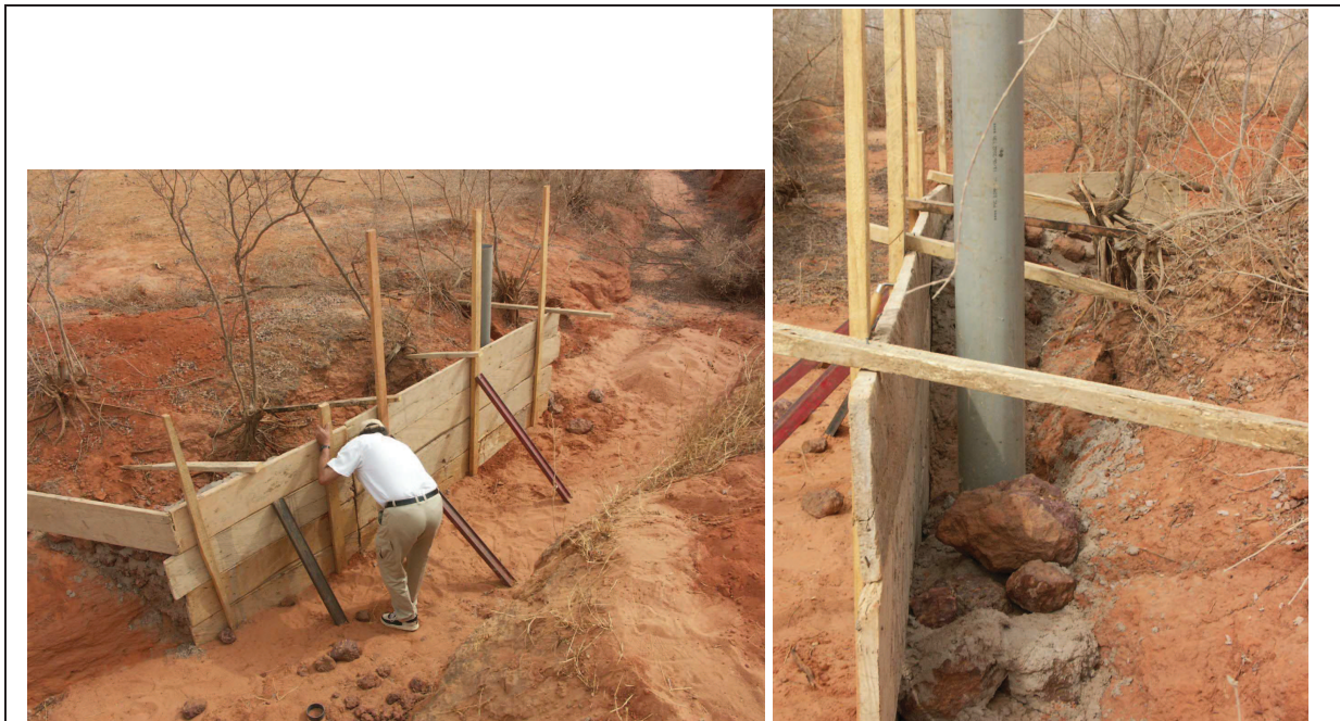
Photos 6 et 7 : Construction d'un seuil artificiel par les techniciens de l'IRD Niamey, Wankama, 2004 (clichés, Le-Breton)
